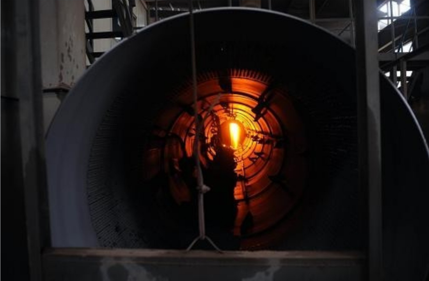
山西省运城市刚玉陶粒砂厂内的高炉煤气隧道窑（11月17日摄）。据该厂介绍，今年年底将把厂内的全部两条隧道窑升级为天然气燃料。
